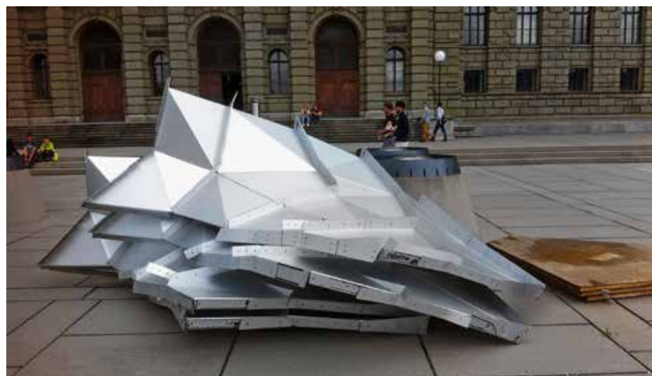
In 25 transportfähige Einzelteile zerlegt wartet der «Rose Pavilion» nun auf einen neuen Standort.
