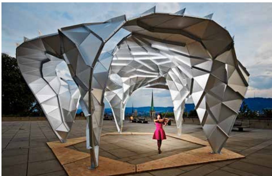
Bei Beschallung beginnen die Bauteile aus Aluminium zu schwingen, so dass der Pavillon wie ein riesiger Lautsprecher wirkt.
